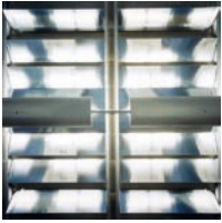
Indirekte Bürobeleuchtung über Breitbandreflektoren.
