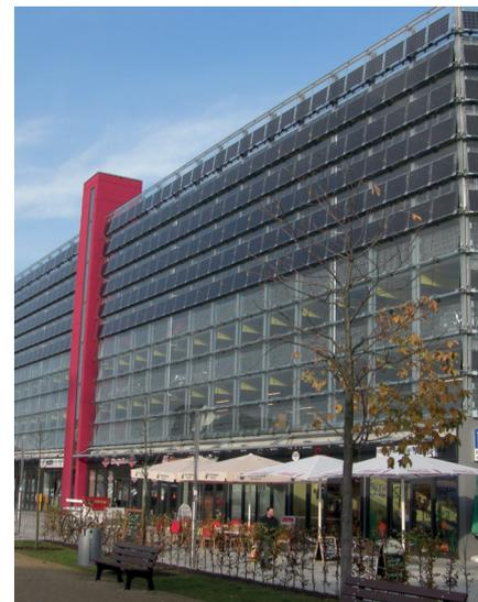
Bild 4 Sonnenschutz-Fassadengestaltung mit Photovoltaikanlagen Parkhaus Roter Turm Chemnitz
