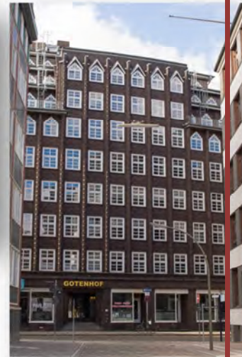
Dienstgebäude in Hamburg, Steckelhörn 12
