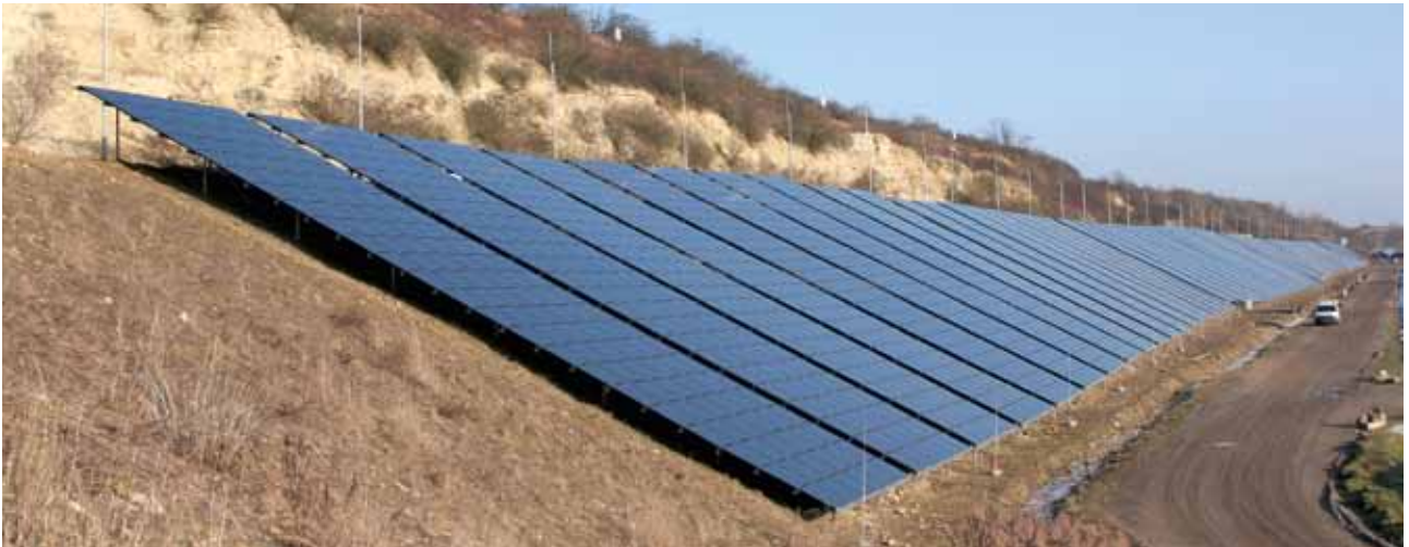
Abb. 1: Fotovoltaik-Freiflächenanlage auf dem Gelände des Dyckerhoffbruchs in Wiesbaden. (Foto: ELW Entsorgungsbetriebe der Landeshauptstadt Wiesbaden, Frank Fischer.)
