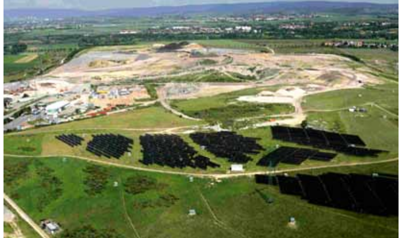
Abb. 2: Fotovoltaik-Freiflächenanlage auf dem Gelände des Deponiepark Flörsheim-Wicker. (Foto: Deponiepark Flörsheim-Wicker.)
