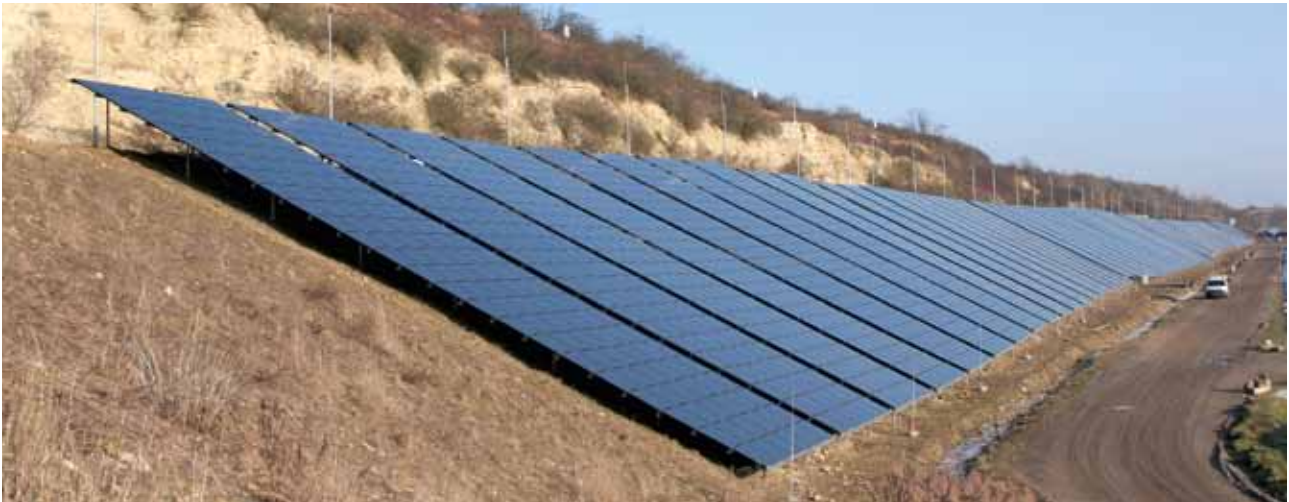
Abb. 1: Fotovoltaik-Freiflächenanlage auf dem Gelände des Dyckerhoffbruchs in Wiesbaden. (Foto: ELW Entsorgungsbetriebe der Landeshauptstadt Wiesbaden, Frank Fischer.)
