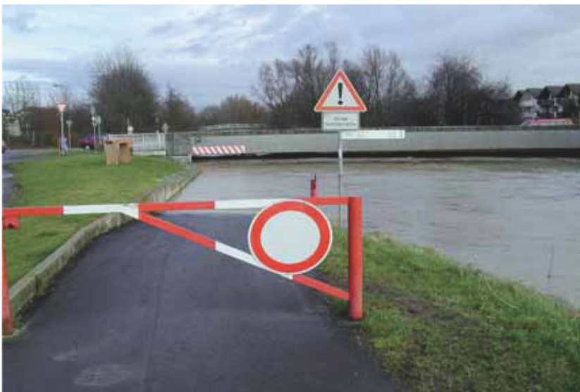
Abb. 1: Hochwasser an der Nidda.
