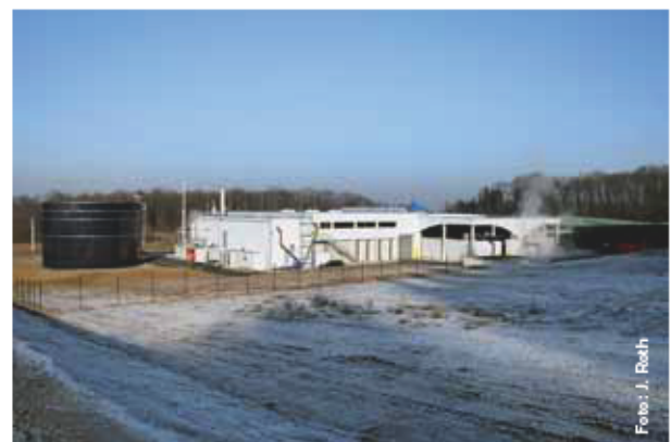
Abb. 2: Vergärungsanlage mit Gärrestbehälter.
