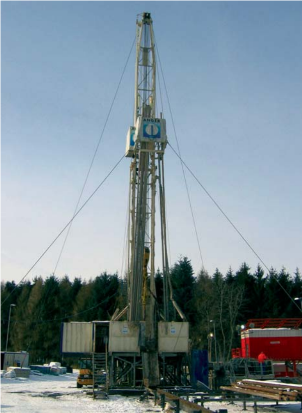
Abb. 3: Bohranlage zum Abteufen tiefer Bohrungen, z. B. Geothermiebohrungen.
