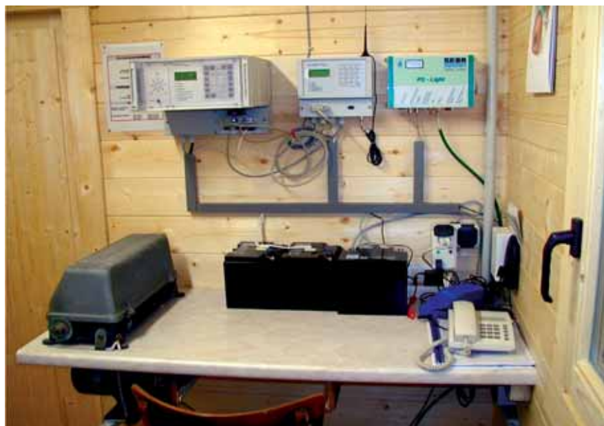
Abb. 4: Pegel Adelshausen an der Pfieffe, ausgerüstet mit redundanter Technik zur Messwerterfassung und -übertragung.
