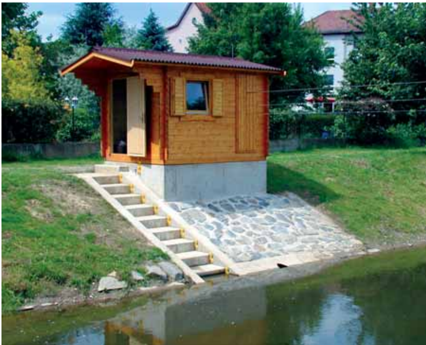
Abb. 2: Neubau des Pegels Friedberg an der Usa.
