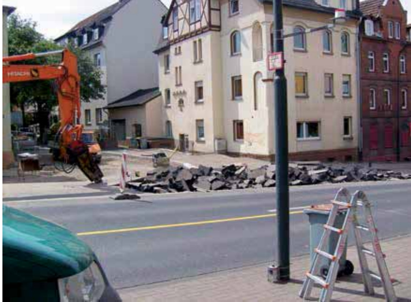
Abb. 2: Probenahmeaufbau im Bereich der Sanierung (Beispiel San2); Wetterschutz mit Probennehmalterung für NO 2 -Passivsammler in 2 Höhen (3 und 0,1 m).
