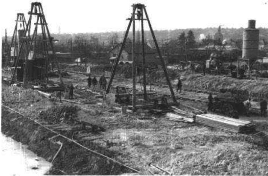
Baustelle 1953; Bohrtürme für Hochhausfundamente.
