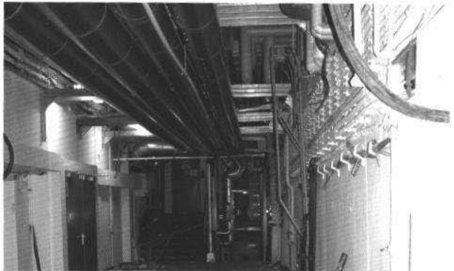
Trassen der Haustechnik im Kellergeschoss des Bauteils A in mehreren Etagen übereinander.
