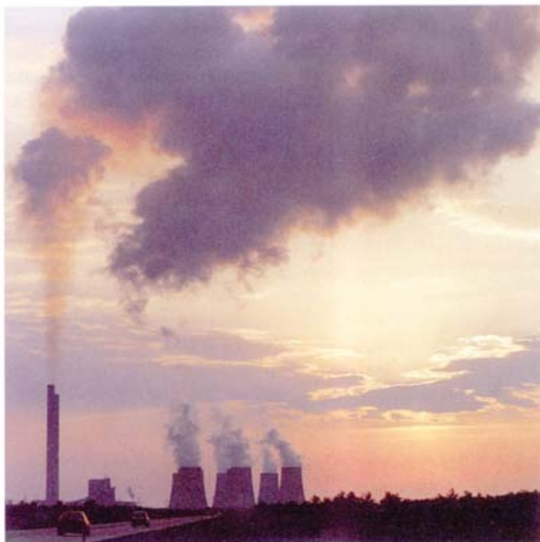
Das Kraftwerk Boxberg: Einst als »Energieriese« und »größtes Braunkohlekraftwerk Europas« gepriesen, heute Symbol für die jahrelange Verdrängung der Umweltprobleme
