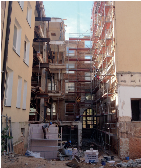
Der Bereich der ehemaligen Verwaltung/Direktion zum Zeitpunkt des Abbruchs der Decken.
