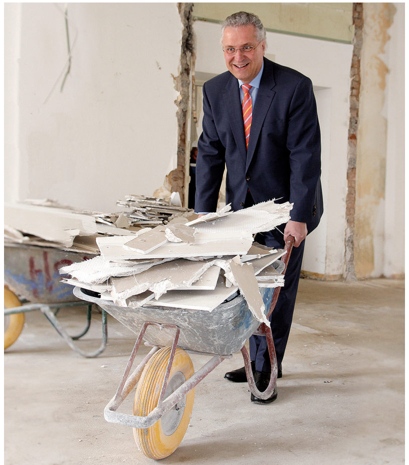
Innenminister Joachim Herrmann am 4. April 2012 beim Start zur Generalsanierung in Fürth.
