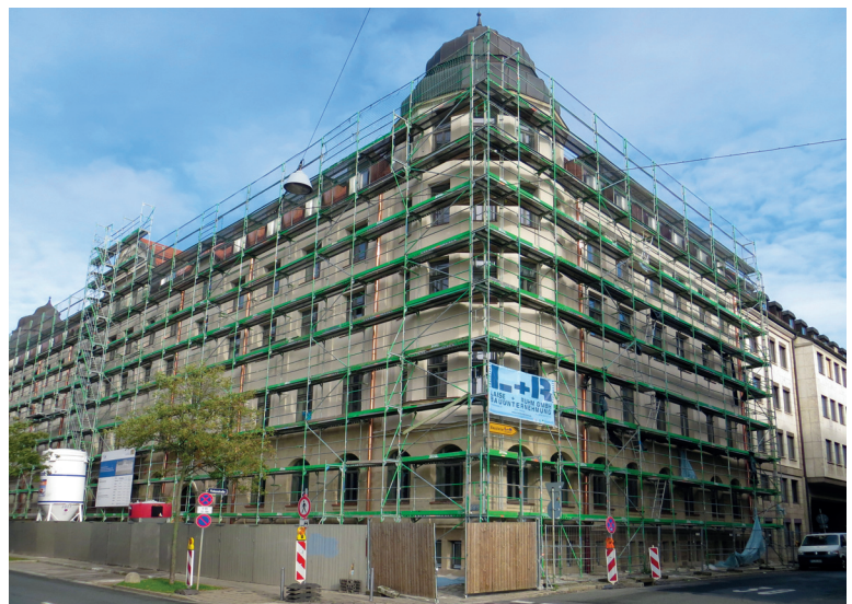
Der denkmalgeschützte Altbau an der Nürnberger Straße – eingerüstet im Oktober 2015.
