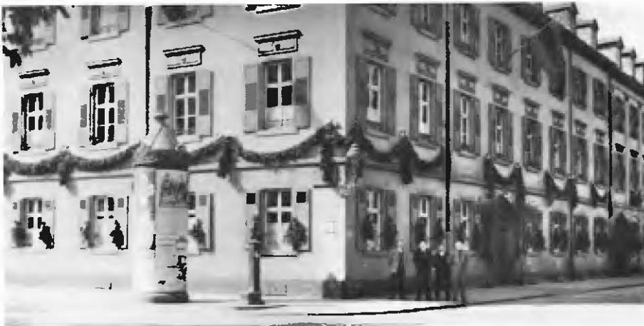
Abb. 10 Amtsgebäude Karlsruhe, Akademiestraße 1-5
