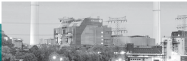
Heizkraftwerk Klingenberg → Berlin
