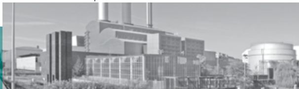
Heizkraftwerk Mitte → Berlin | Blick von der Michaelbrücke
