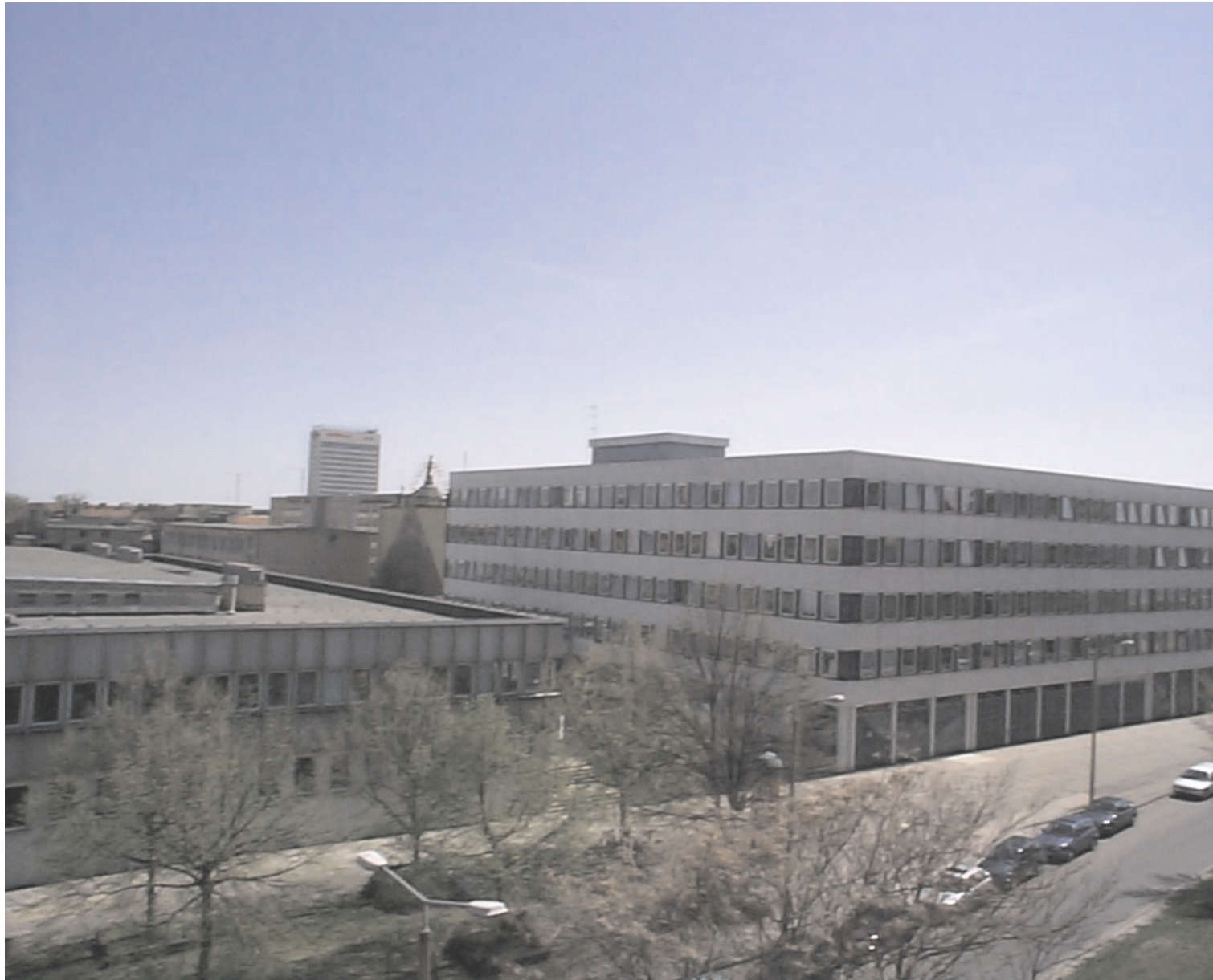
Hauptgebäude des Landesbetriebes für Datenverarbeitung und Statistik Brandenburg in Potsdam, Dortustraße 46
